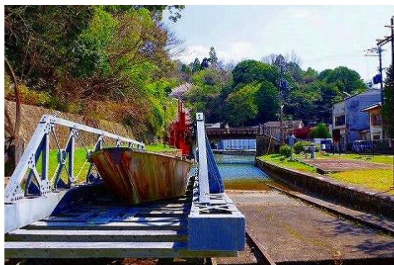
蹴上インクライン／船を台車に乗せて移動するシステム
